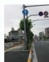
左側の歩道は1車線分となっている
