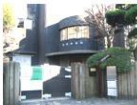
朝倉彫塑館（工事中）
