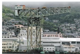
現在のハンマー・ヘッドクレーン
